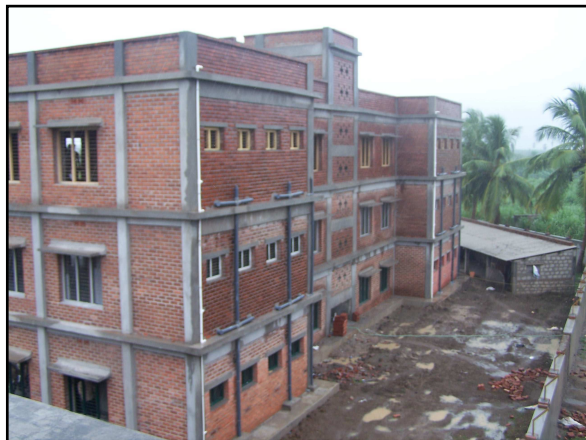
Das Gebäude für "Balika" ist bereits in Arbeit.
